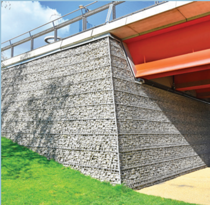
Gabionvegg i knust betong
