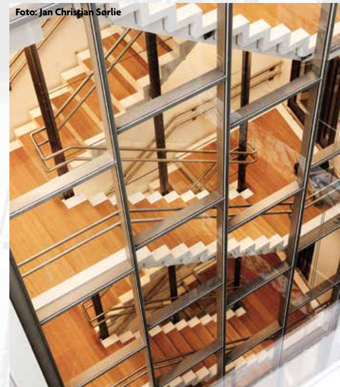
SpareBank 1 Midt-Norges hovedkontor; eksponert betong tar opp varmen som genereres i løpet av dagen av mennesker og utstyr
