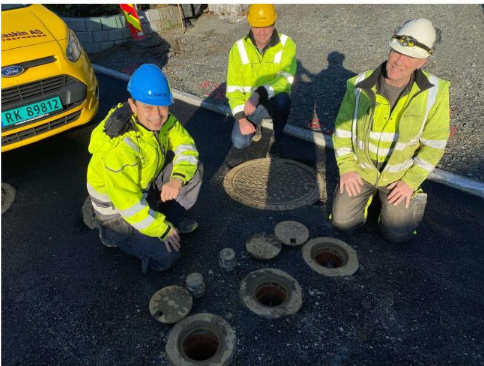
Christian J. Engelsen (SINTEF Community), Bengt Møller (stikningsansvarlig, Nordbø Maskin) og Helge Wiken (formann, Nordbø Maskin) viser de flytende rammene i asfalten i ett av testfeltene der toppen av setningsmålerne befinner seg. Foto: SINTEF
