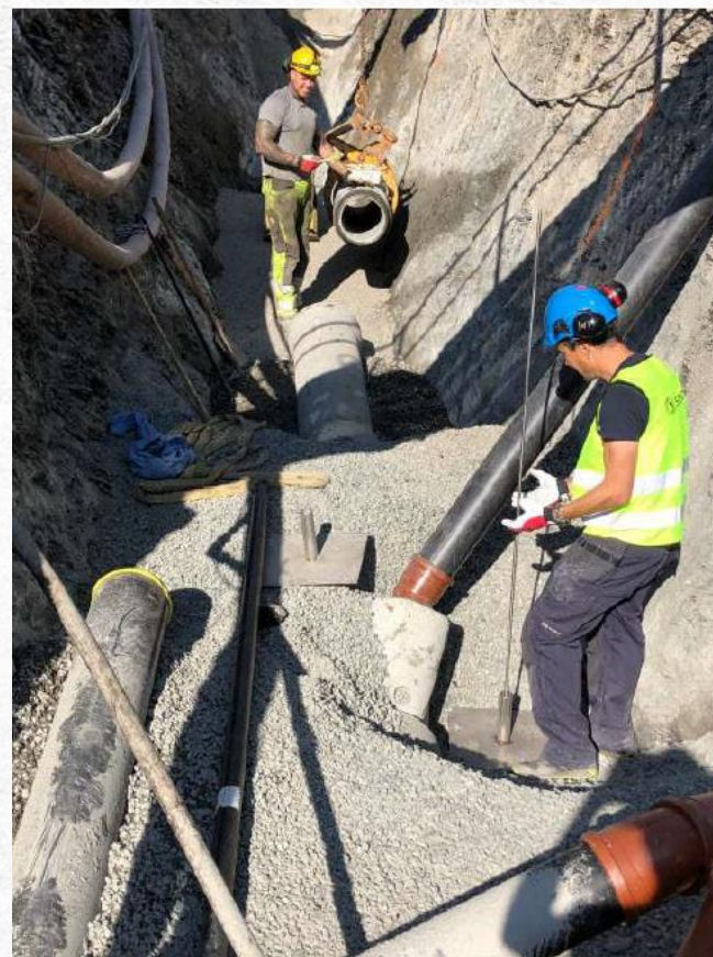
Plassering av setningsmåler (1-3) i forskjellige høyder i Liveien.
