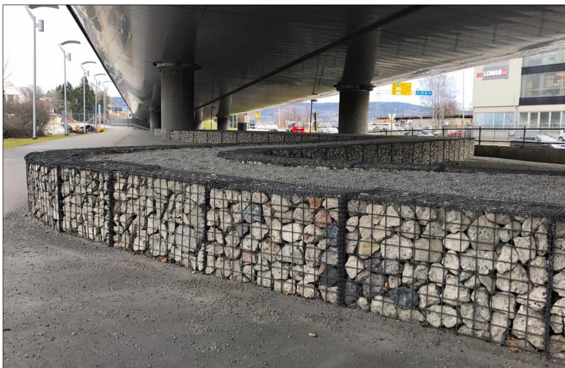
Figur 16 Gabioner fylt med knust betong kan være en nyttig måte å utnytte rivningsbetong på. De kan for eksempel brukes til å lage støttemurer. En annen positiv miljøeffekt er at den knuste betongen vil oppta CO 2 fra atmosfæren gjennom økt karbonatisering. Foto: Betongfokus
