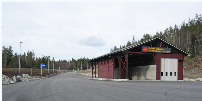
Fig. 1. I påkjøringsrampen til E6 fra Taraldrud kontrollstasjon syd for Oslo har Statens vegvesen benyttet bl.a. knust betong i forsterkningslaget.
