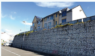
Fig. 3. Støttemur bygget med knust betong i (Newport, Isle of Wight, England)
