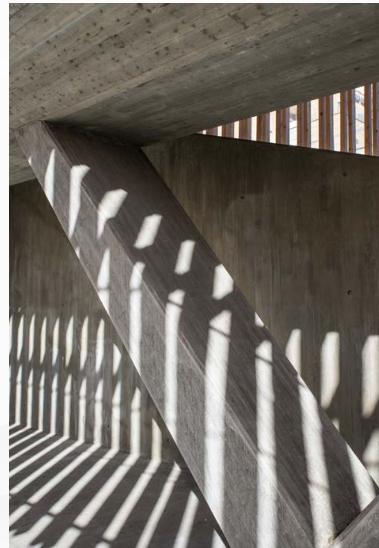
Bekkestua stasjon Foto: Jiri Havran
