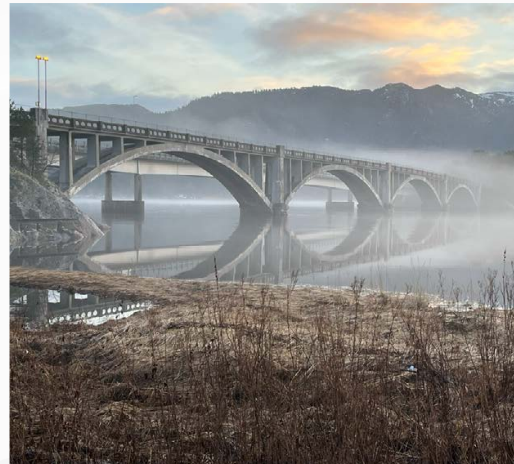
Namsbrua har inspirert komiteen til å dele gode betong-historier. Foto Sverre Smeplass
