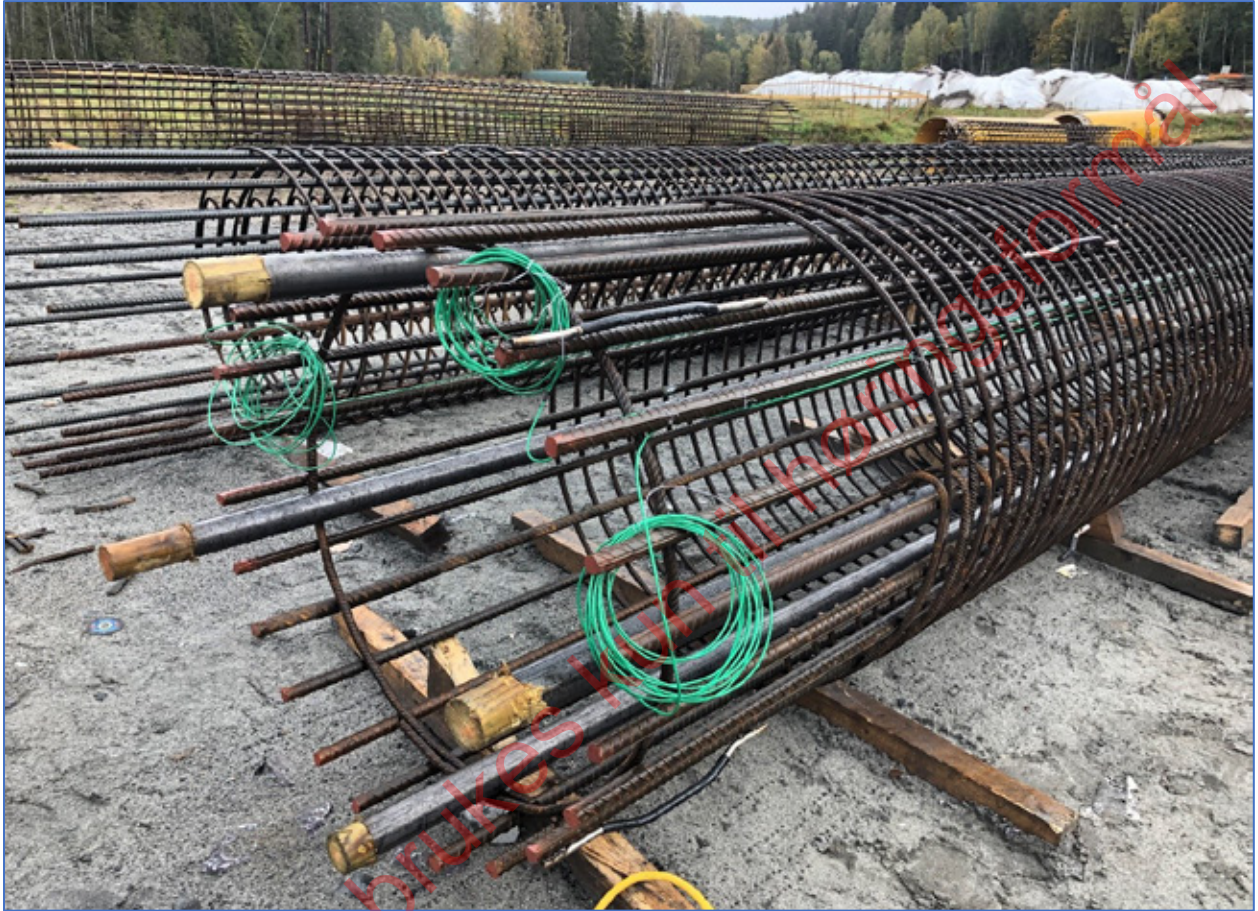
Foto 6 Plassering av inspeksjonsrør på innsiden av armeringskurv
