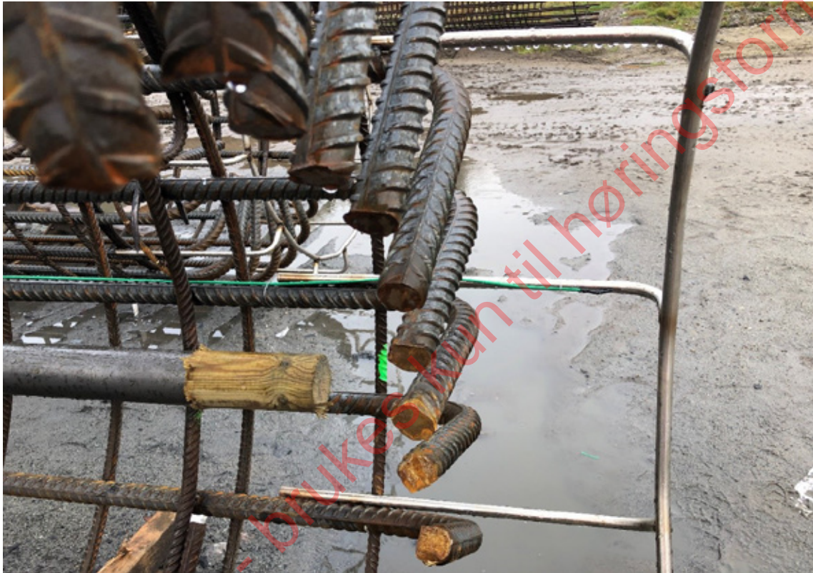
Foto 8 Eksempel på påsveist avstandsholder for armeringskurv til pilar
