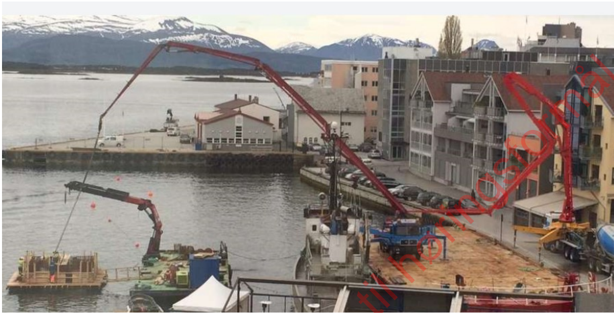
Foto 4 Pumpeutlegg, AUV-betongen testes for planlagt metode. (Syltosen/Molde
