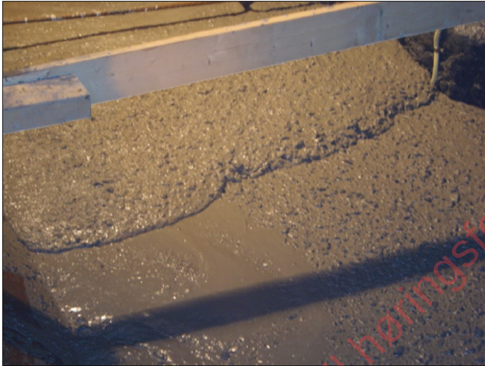
Figur 3.8 Støpeflo som flyter over et lag med tiksotropisk tilstivning, Nye Tyin Kraftverk, Øvre Årdal
