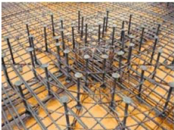
Figur 32 Armering mot gjennomlokking rundt en søyle
