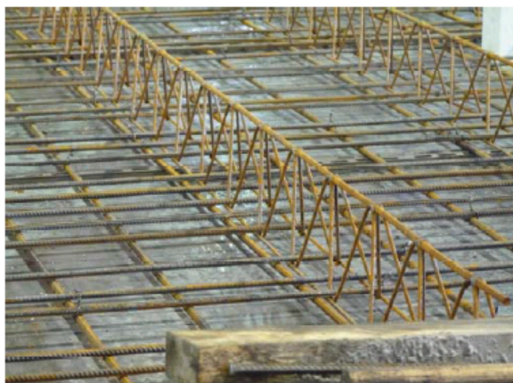
Figur 29 Gitterdrager montert i form
