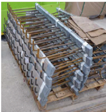
Figur 27 Skjøtejernskassetter som levert
