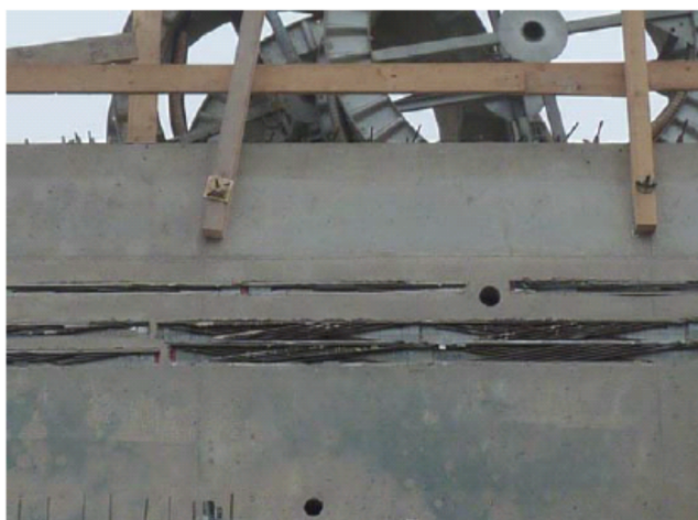
Kassettenes innstøpt etter forskalingen er revet (skjøtejern ikke bøyd ut ennå)
