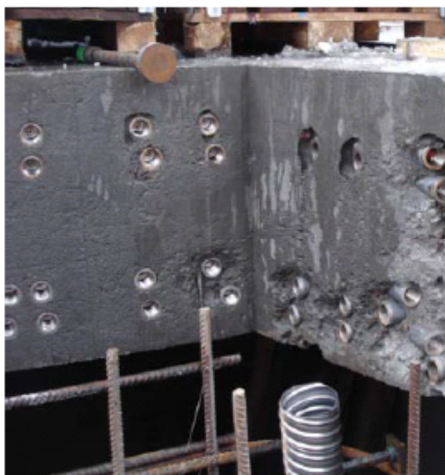
Figur 26 Bruk av skjøtekoblinger: Ingen utstikkende armering – forbedret tilgang og økt sikkerhet
