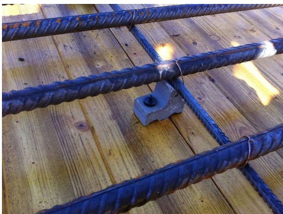
Figur 33 Armeringsstol som understøttelse for et armeringsnett og avstandsholder for OK-armering
