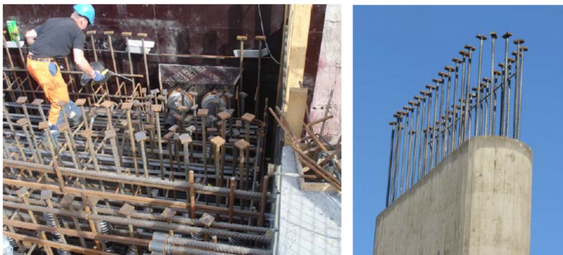
Figur 28 Forbedret tilgjengelighet ved bruk av T-hodet armering T-hodet armering i toppen av brupilar
