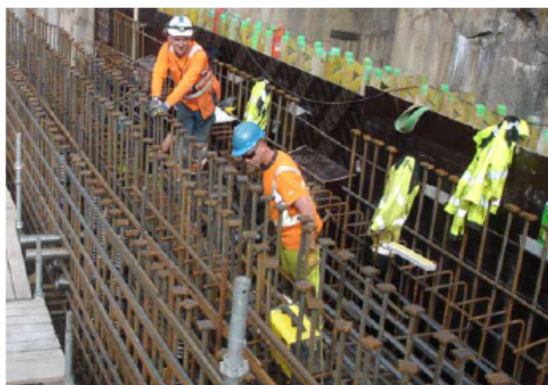
Figur 41 Forbedret tilgjengelighet gjennom erstatning av forankringsbøy med T-hodet armering
