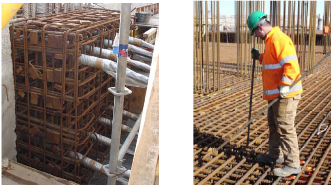
Figur 42 T-hodet armering ved forankring av spennarmering T-hodet skjærarmering i en bunnplate (forhindret tverrutvidelse)
