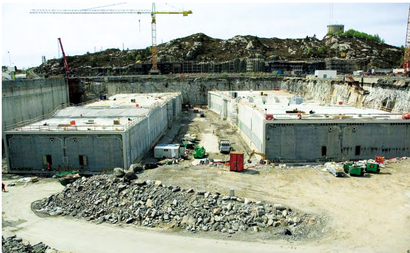
To av betongelementene til senketunnelen i Bjørvika er her ferdigprodusert på Hanøytangen.
