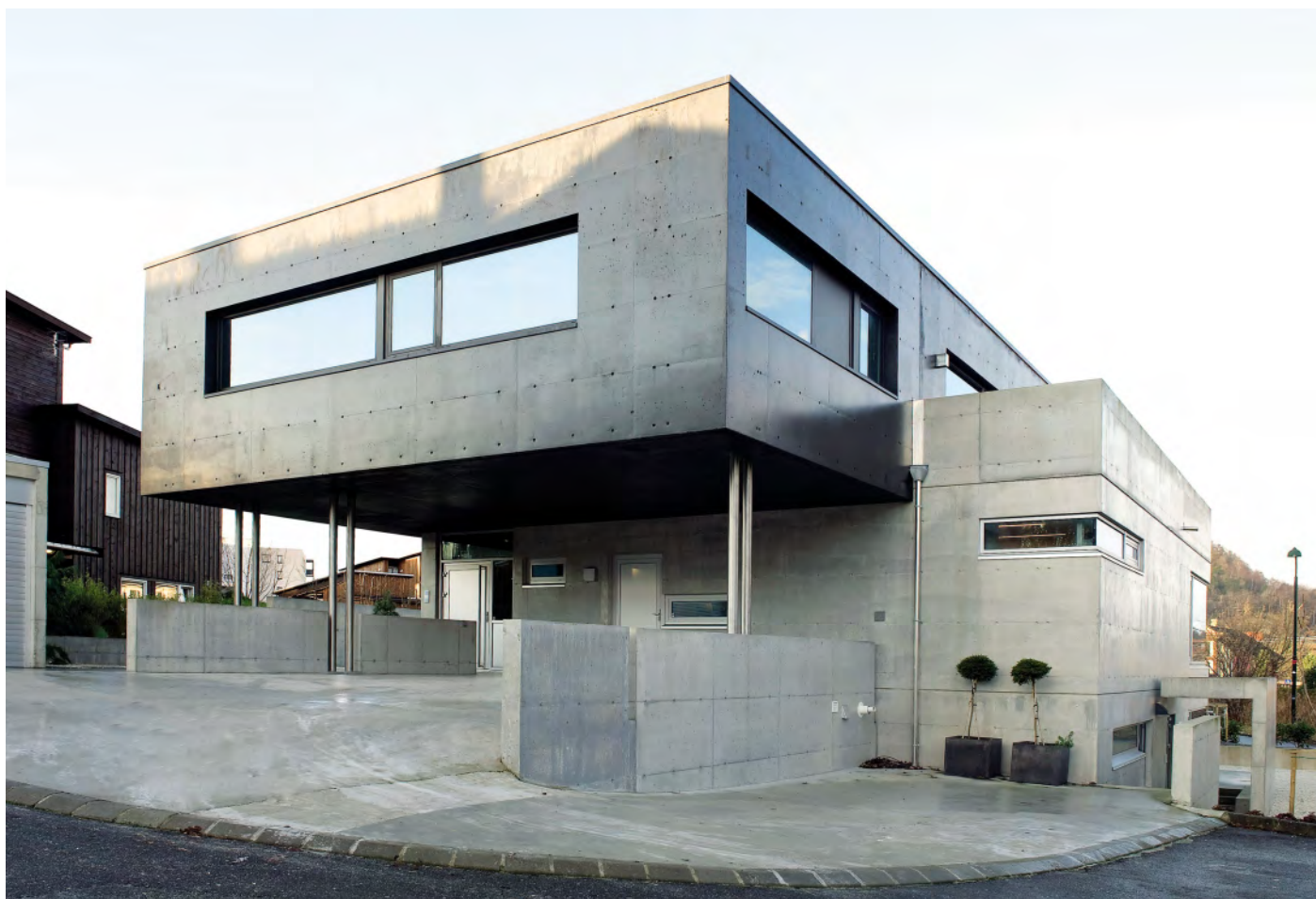
Boliger i betong blir stadig mer vanlig. Denne eneboligen i Stavanger er tegnet av RAMP Arkitekter AS.
