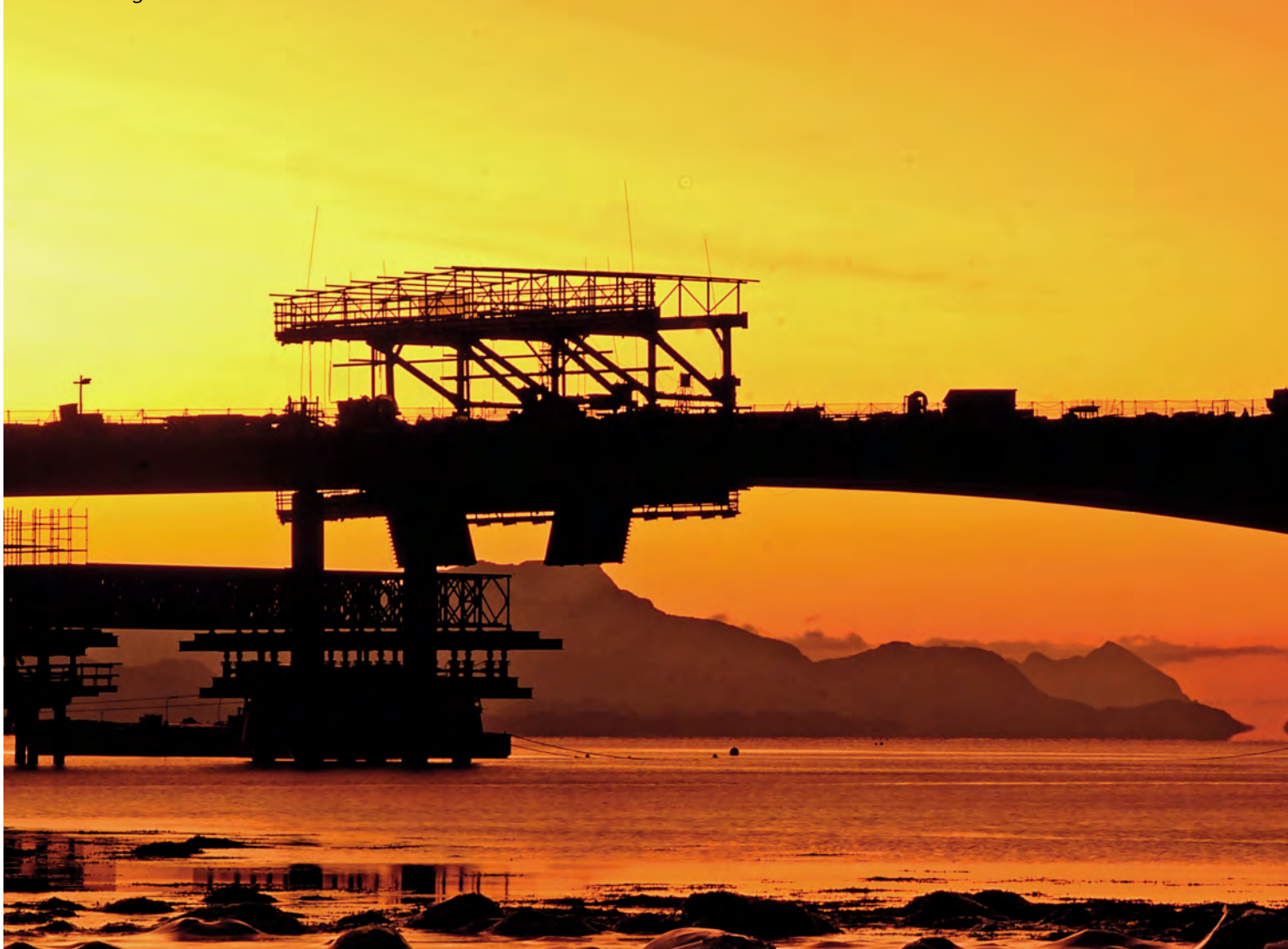
Tverlandsbrua. Photo: Torbjørn Braset/ Statens vegvesen
