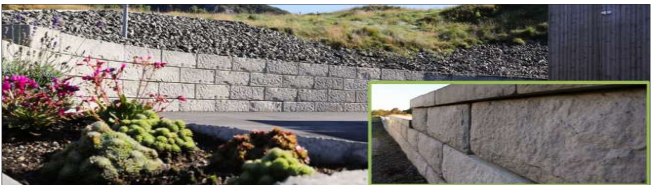
Figur 11: Reconblokker støpt av returbetong. Foto: Sandnes & Jærbetong AS
