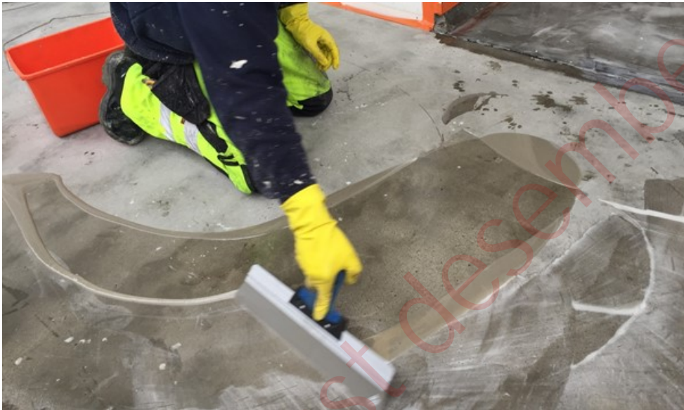
Figur 9-11 påføring av primer tilsatt sand med glatt sparkel
