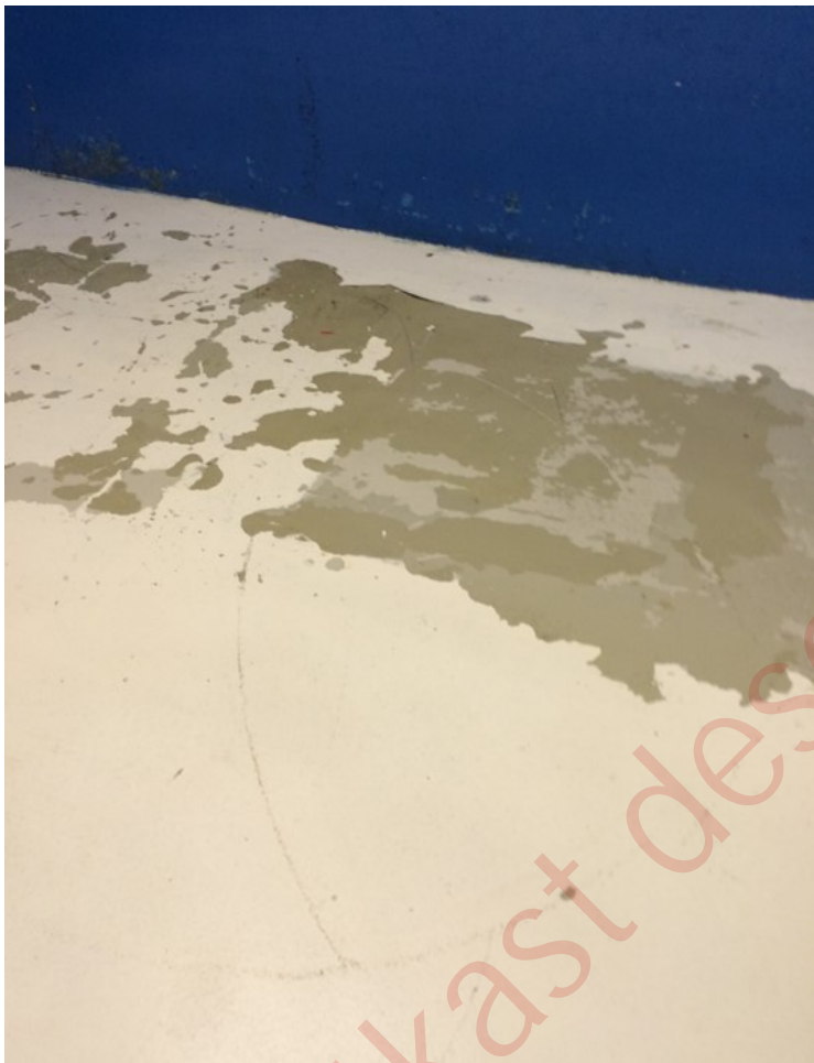
Figur 9-21 avflassing av belegg
