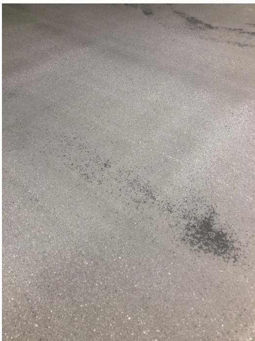
Figur 6-3 Overflate etter slyngrensing
