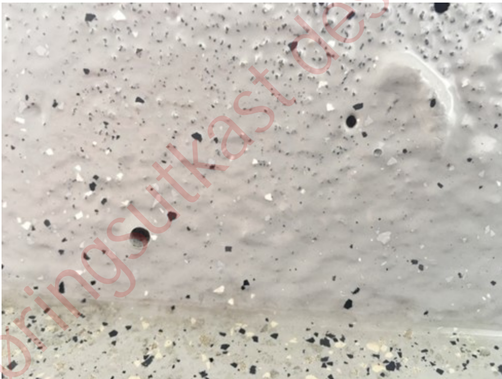
Figur 9-5 porer på oppkant
