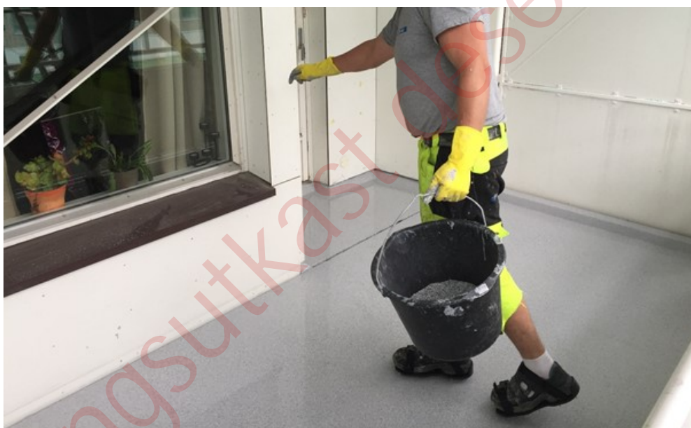
Figur 9-13 påføring av flakes
