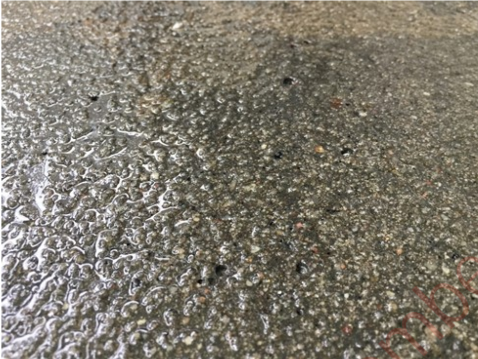
Figur 9-6 overflate av betong etter priming hvor porer er godt synlig
