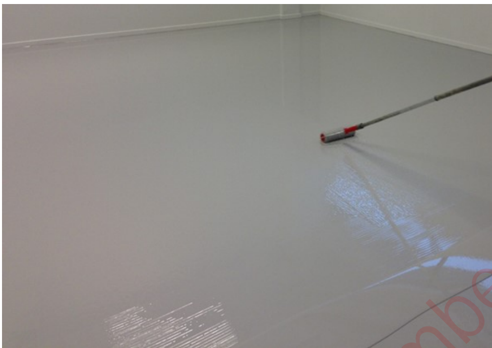
Figur 9-12 fjerning av luftporer med nårull
