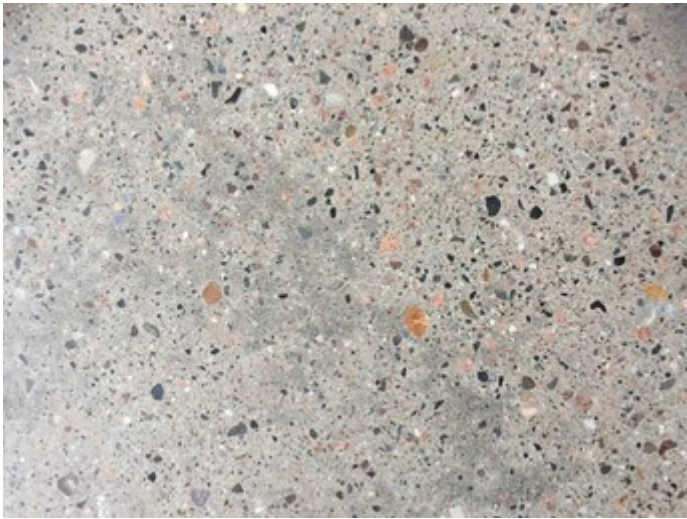
Figur 6-1 Eksempel på slipt betongoverflate.
