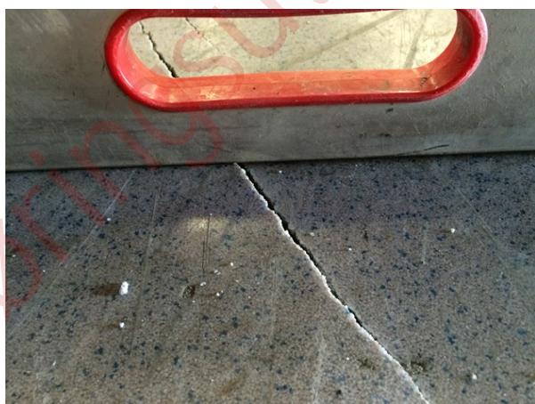
Figur 9-19 kantreising ved riss
