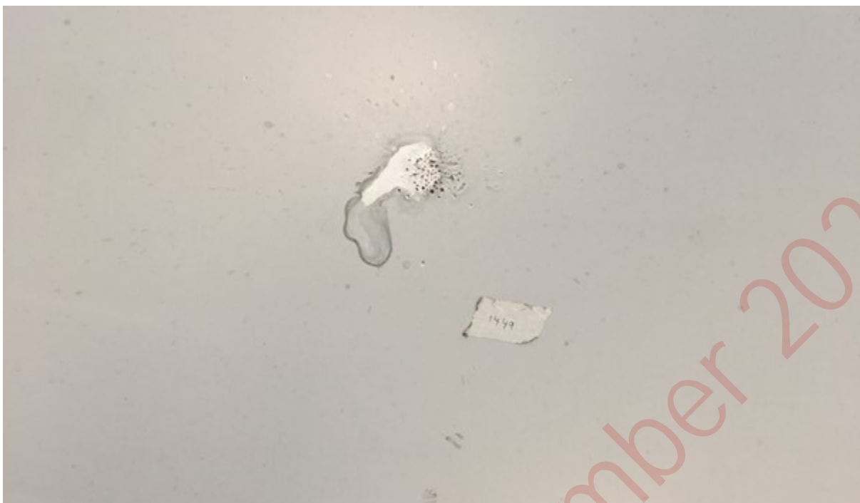
Figur 9-14 blærer på grunn av fuktighet
