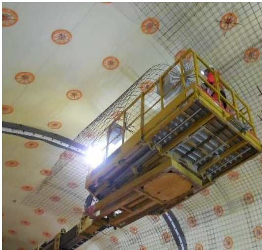
Figur 4-10: Venstre: Montasje av armeringsnett på bolt, foto: Veidekke Entreprenør AS. Høyre: Korrosjonsbeskyttet blekksprut [7]
