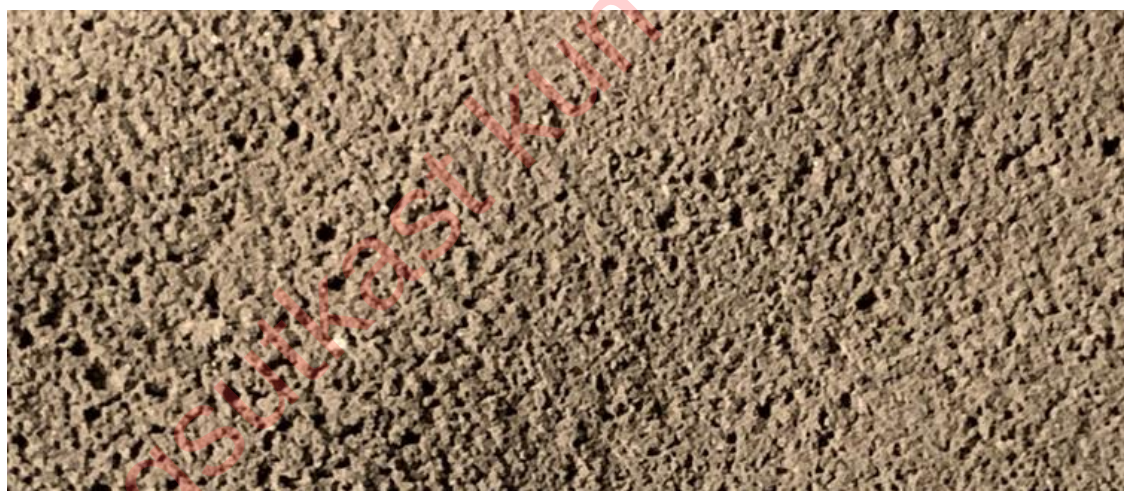
Figur 4-8: Bilde av fersk sprøytet betong, med sine karakteristiske ujevnheter i overflaten.
