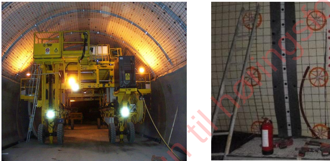
Figur 4-9: Venstre: Montasje av armert sprøytebetonghvelv-konstruksjon. Høyre: Tilgjengelig brannsluknings-apparat ved montering. Foto: Veidekke Entreprenør AS
