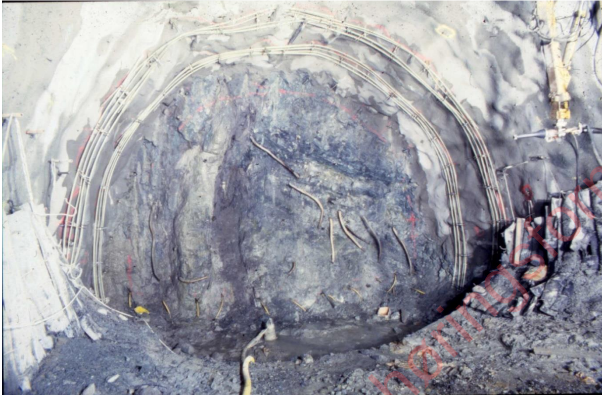
Figur 3-5: Utførelse av bergsikringen vist i figur 4, der armeringen i sikringsbuene er montert og klare for innsprøyting med betong. Fra drivingen av undersjøisk tunnel til Bjørøy og et parti med meget svakt berg og mektige spalteåpninger fylt med ukonsolidert sand. (foto Karl Gunnar Holter)
