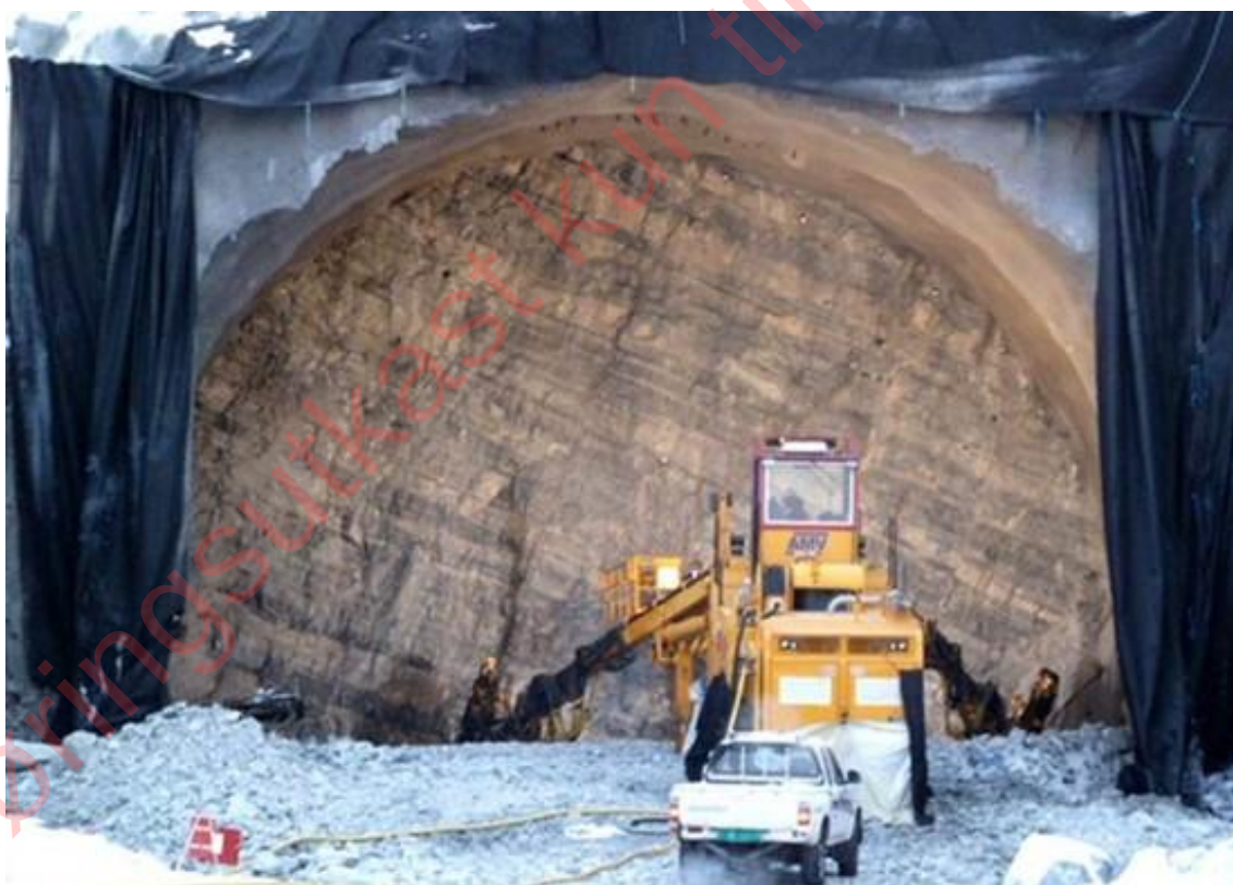
Figur 3-2: Bergsikring med armerte sprøytebetongbuer og forbolter utført de første 3 salvene fra påhugget. Bergblokker og mindre bergfragmenter holdes på plass av bergsikringen. Selv bærende hvelv av bergmasse oppnås ved en jevnt sprengt bergkontur i tunnelperiferien. Påhugg Holm i Holmestrandporten. Foto: Bane NOR Utbygging
