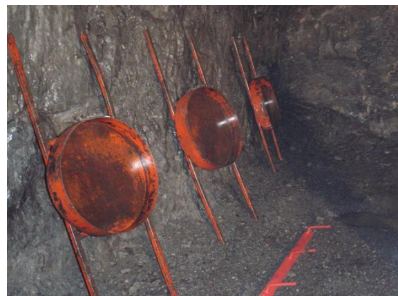
Figur 2-2: Plateformer klare for sprøyting
