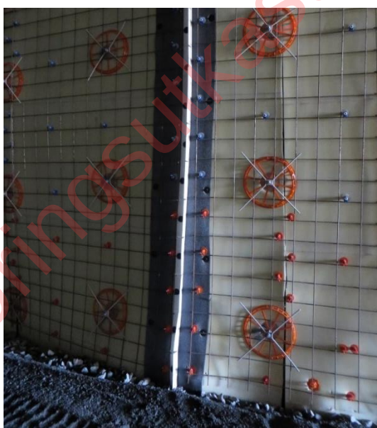
Figur 4-13: Venstre: Etablering av dilatasjonsfuge. Høyre: Nærbilde dilatasjonsfuge. Foto: Veidekke Entreprenør AS
