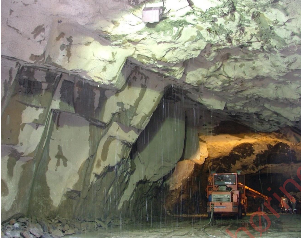
Figur 3-3: Manglende buevirkning i bergmasse med betydelige overmasser som gir ugunstig og instabil kontur. Tilpasset bergsikring med omfattende bolting av store bergblokker og 6-8 cm tykk sprøytebetong for detaljsikring. Sao Paolo Metro Linha 3. Foto Nick Barton.
