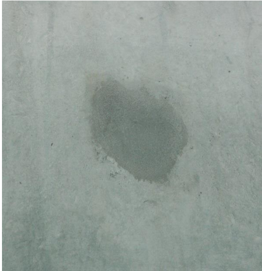
Bilde 28 Eksempel på godt synlig, pusset reparasjon
