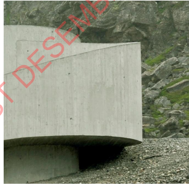
Bilde 31 Eksempel på mindre synlig reparasjon, i motsetning til reparasjonene i bildene over er det her funnet reparasjonsmørtel med tilsvarende fargenyanse og struktur som opprinnelig betongoverflate
