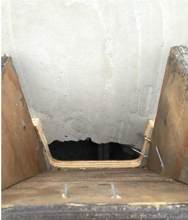
Bilde 34 Reparasjon med betong, fylling
