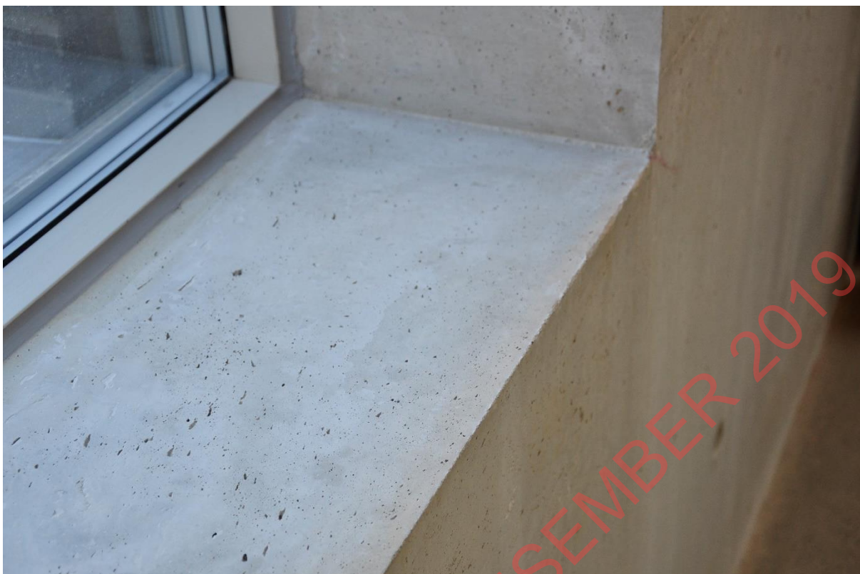
Bilde 16: Rett hjørne ved vindusmyg.
