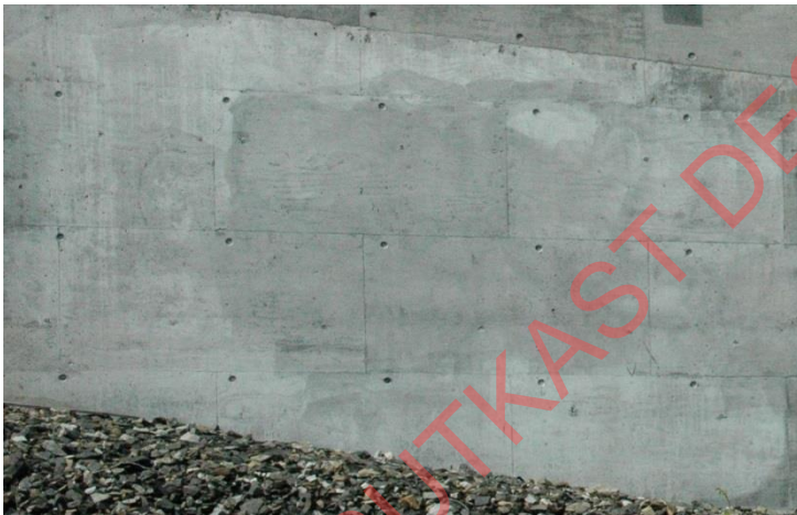
Bilde 25: Resultat av ujevn påføring av formolje.
