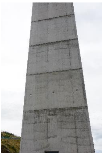
Bilde 27: Nærbilde av tårn på Hardangerbrua som viser støpefronten som mørke streker i overflaten, i tillegg til kaldskjøter mellom stlpeavsnittene. (foto: Lise Bathen)
