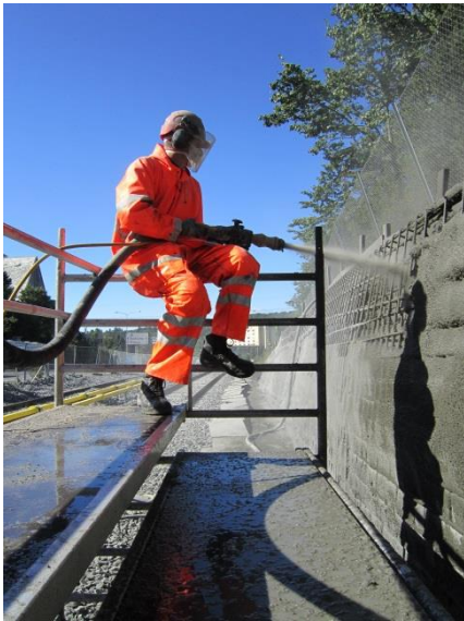
Bilde 36 Sprøyting av tørrsprøytebetong (foto: Entreprenørservice)
