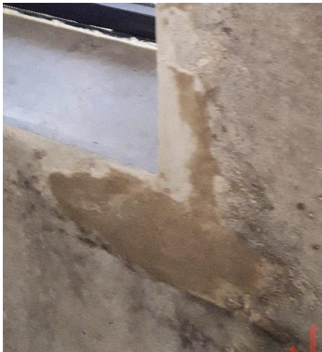
Bilde 44 Reparert hjørne med mørtel, før lasering.
