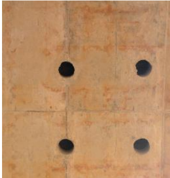
Bilde 20: Rustmerker på overflaten.
