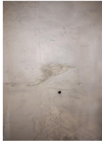
Bilde 43 Samme betongoverflate som bildet til venstre, men overflaten er overflatebehandlet med lasering
