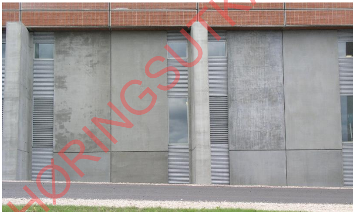
Bilde 4 Betongelementbygg med betydelige fargevariasjoner og skjolder til tross for at man har benyttet samme betongresept under produksjonen. Fargeforskjellen er sannsynligvis forårsaket av forskjell i herdetid, mens skjoldene antageligvis kommer av dårlig forskalingsrengjøring eller feil påføring av formolje.
