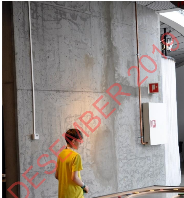
Bilde 33 Reparasjon av støpesår påvirker sluttresultatet i stor grad.
