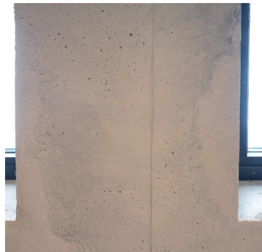
Bilde 47 Reparert hjørne etter lasering.
