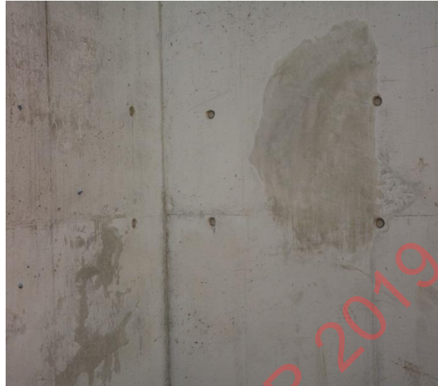
Bilde 29 Eksempel på godt synlig reparasjon på grunn av ulik farge og struktur på reparasjon og betongoverflate.
