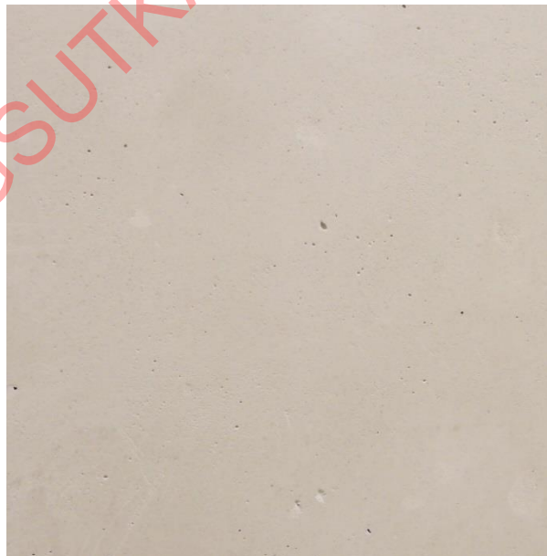
Bilde 37 Eksempel på betongoverflate med porefylling (fra Østbanehallen, Oslo)
