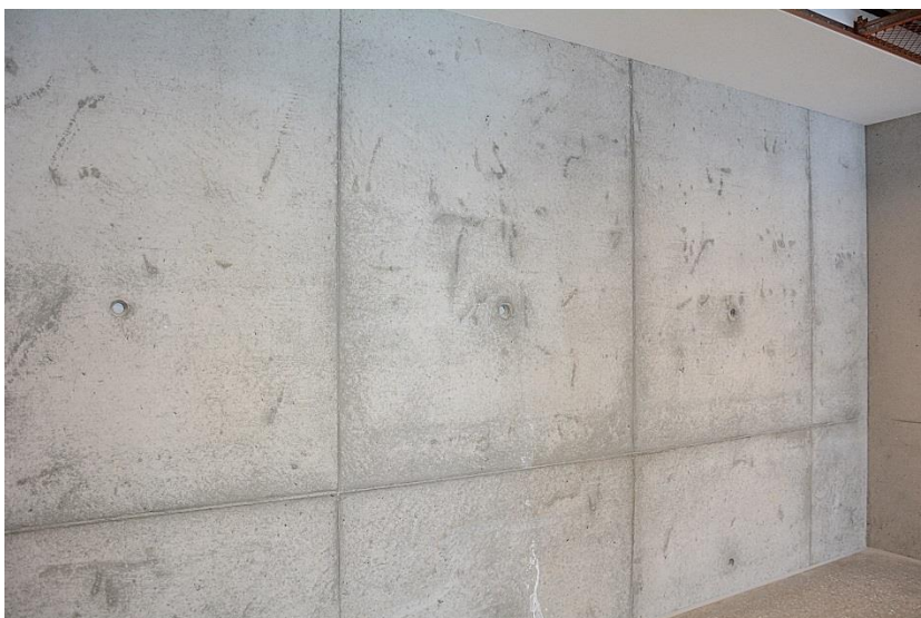
Bilde 22: Resultat etter bruk av finerlemmer med skader.
