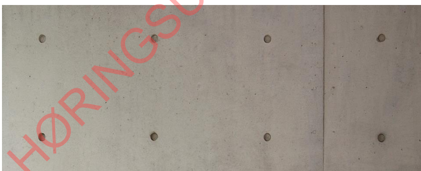
Bilde 17: Plassering av staghull gir et tydelig mønster i overflaten (foto: Ole H. Krokstrand)
