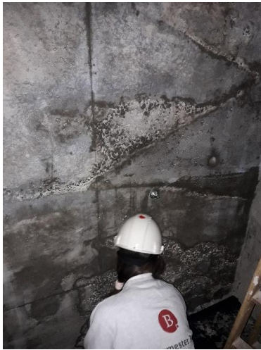
Bilde 42 kraftig skjolding, samt reparasjon på betongoverflate
