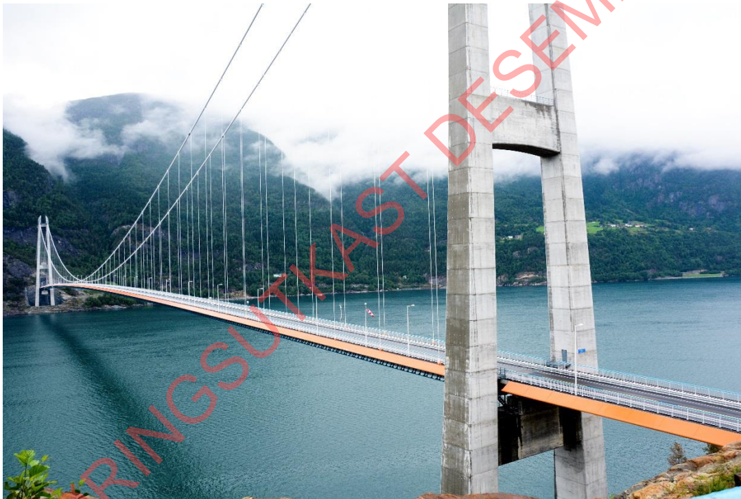
Bilde 26 Hardangerbrua, eksempel på mørke streker som ikke må forveksles med kaldskjøter. De mørkeste strekene er kaldskjøter mellom støpeavsnitt. Foto: Ole Krokstrand.
