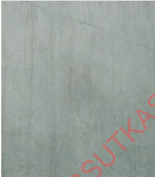
Bilde 30 Eksempel på mindre synlig reparasjon, , i motsetning til reparasjonene i bildene over er det her funnet reparasjonsmørtel med tilsvarende fargenyanse og struktur som opprinnelig betongoverflate.
