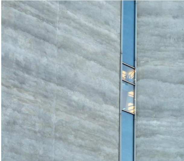
Bilde 49 Kalkutslag på fasadevegg
