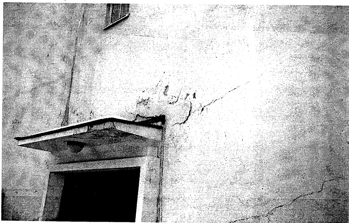
Fig. 1.1 Riss/krakelering i overflatebehandlingen
