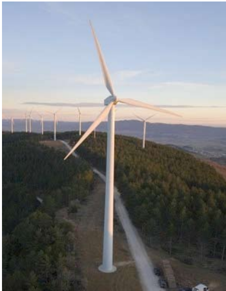
Figur 8: Vindmølle i prefabrikkert betong fra spanske Inneo Torres 14
