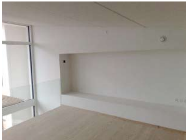
Figur 15: Eksponert betongdekke i tak Foto: Hundsbaek & Henriksen A/S
