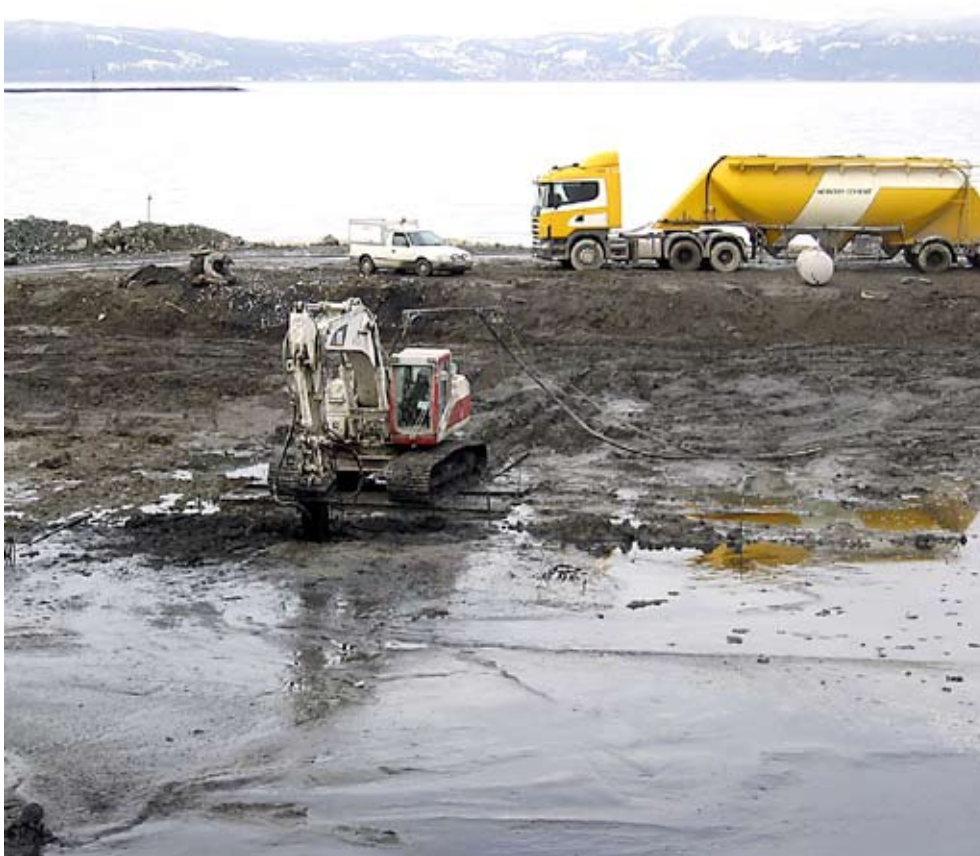
Figur 28: KC behandling i Trondheim havn. Forurensede masser er mudret og fraktet til deponi i strandkanten. Stabiliseringsriggen oppholder seg på stabilisert grunn og arbeider seg videre utover
