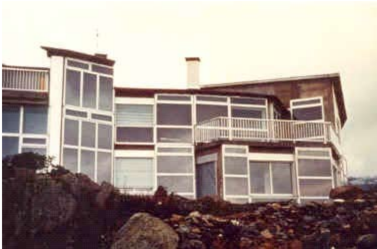
Figur 18: De svarte glassfeltene består av Trombe vegger Foto: ukjent
