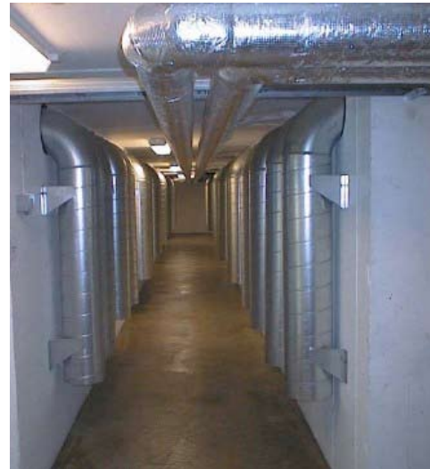
Figur 21: Betongkulvert på HiNT. Bilde: Hans Martin Mathisen
