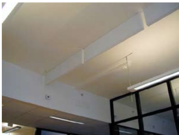
Figur 11: Eksponert betongdekke med nedhengte akkustiske baffler Foto: Veidekke
