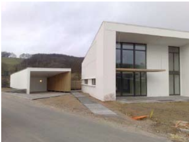
Figur 14: Huset sett utenfra Foto: Hundsbaek & Henriksen A/S
