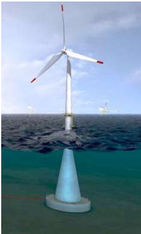
Figur 10: Vici Ventus betongunderstell 17
