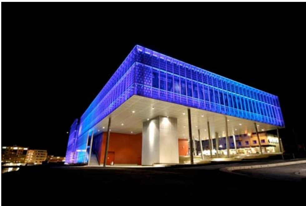
Figur 30: Hammerfest kulturhus som er bygd på sementstabiliserte bunnsedimenter
