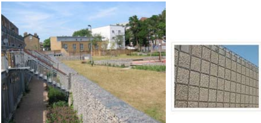
Figur 43: Støttemur i bakgård 57 og støttemur langs atkomstvei for anleggsmaskiner
