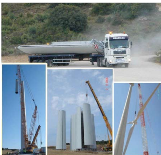
Figur 9: Transport og montasje av Inneo Torres vindmølle-elementer 14
