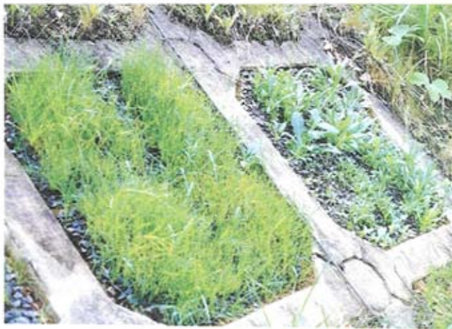
Figur 40: Elveskråning med delvis prefabrikerte elementer og plasstøpt betong
