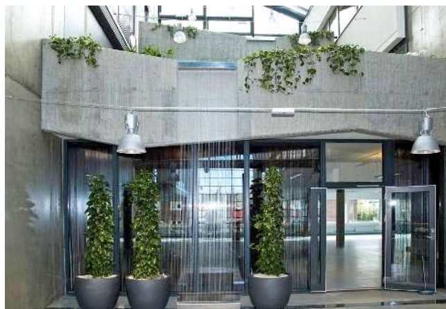
Figur 12: Eksponert betongflater i glassgård Foto: Veidekke
