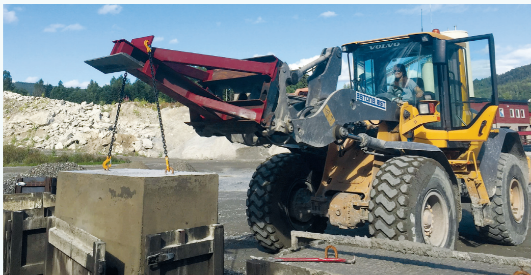
3.000. Betong Øst har totalt omsatt cirka 3.000 lodd årlig noe som tilsier i overkant 2.500 m 3 med returbetong. Foto: Betong Øst
