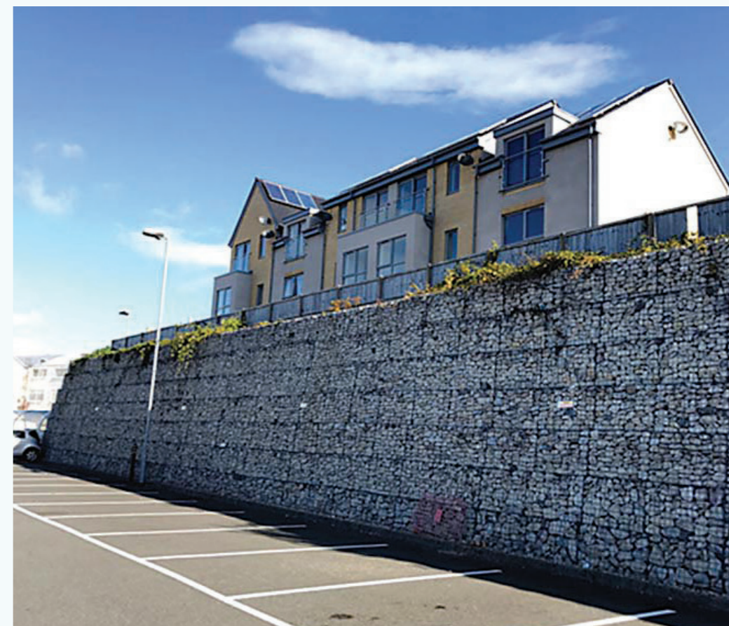
Fig. 3. Støttemur bygget med knust betong i (Newport, Isle of Wight, England) Foto: Jan Eldegard Hjelle, FABEKO
