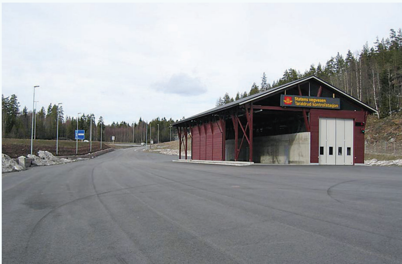
Fig. 1. I påkjøringsrampen til E6 fra Taraldrud kontrollstasjon syd for Oslo har Statens vegvesen benyttet bl.a. knust betong i forsterkningslaget. Foto: Christian J. Engelsen, SINTEF Byggforsk
