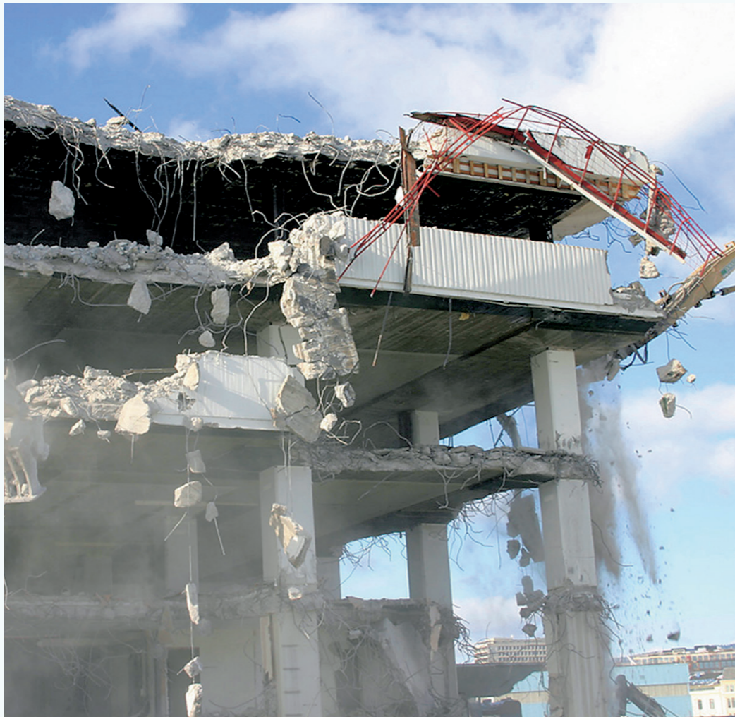
Godt armerte betongkonstruksjoner ble på Tjuvholmen i Oslo og ble resirkulert.
