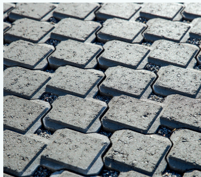
Eksempel på permeabelt dekke med definerte fuger med fugemateriale. Foto: ASAK Miljøstein.
