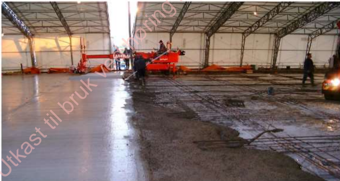
Figur 5.2 Typisk støp av peleunderstøttet SFRC plate (Hedebratt 2001)
