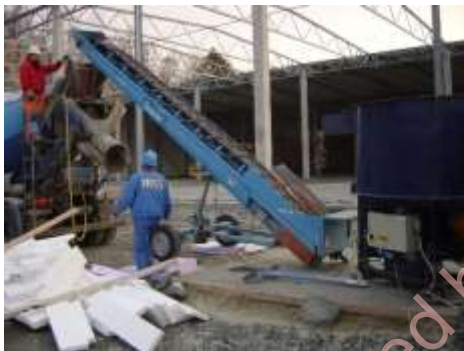
Figur 5.12: Tilsetting av fiber med transportbånd til venstre og med innblåsing på byggeplass fra spesialhenger.
