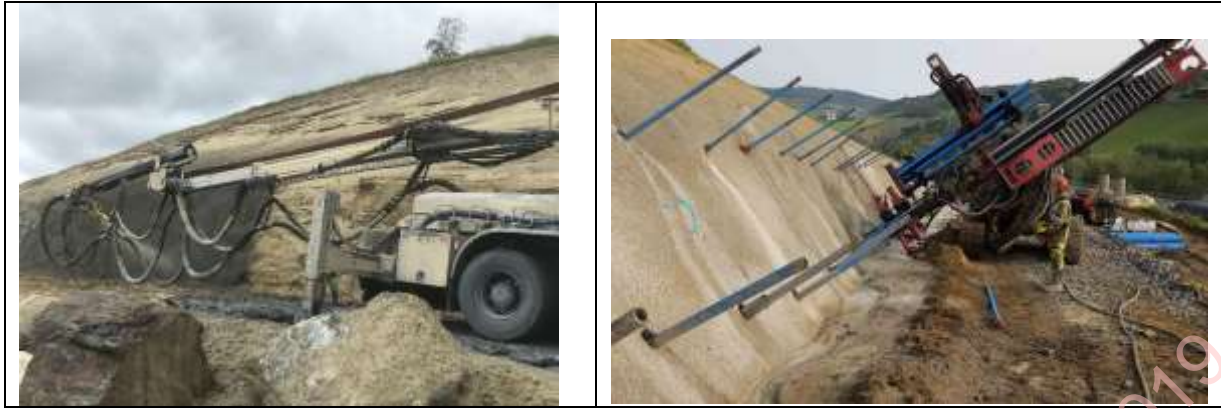
Figur 5.7: Jordnaglingsmur, utførelse av første/øverste utgravingsetappe. Sprøyting (venstre) og bolting (høyre). Foto: Statens vegvesen
