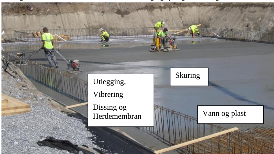
Figur 5.6: Herdetiltak ved dekkestøp.
