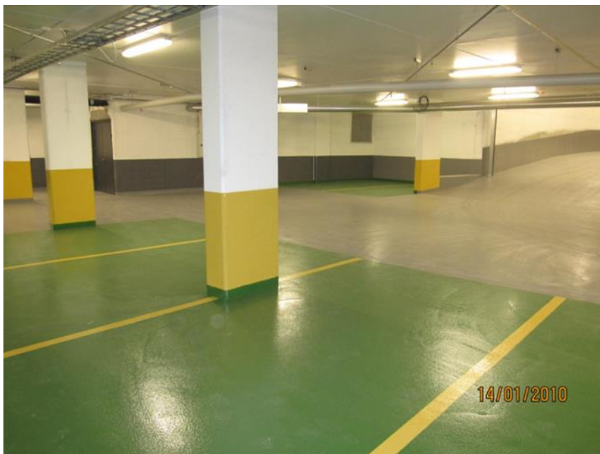
Figur 3.2: Plasstøpt betong med belegg.
