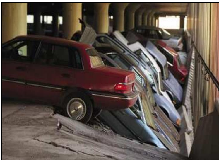
Figur 2.1 Byggeår 1983- Kloridkorrosjon angriper ulikt rundt og over lengden av jernet.
