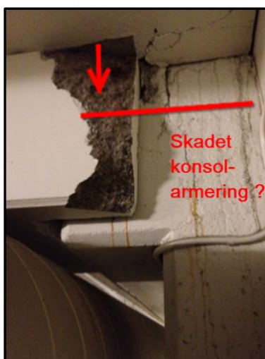
Figur 2.8 1980-tallet - Saltholdig vann renner ned fra parkeringen over
