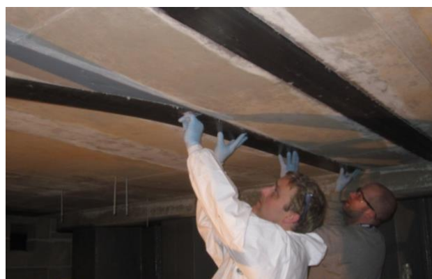
Figur 4.4 Oppliming av karbonfiber under dekke.
