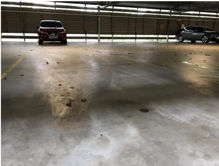
Figur 3.5: Høyfast mørtel på plasstøpt betong der det ikke er bevegelige riss og sprekker eller annen bevegelse i betongkonstruksjonen.
