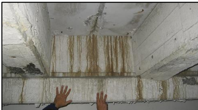
Figur 2.8 1980-tallet - Saltholdig vann renner ned fra parkeringen over
