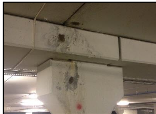
Figur 2.8 1980-tallet - Saltholdig vann renner ned fra parkeringen over
