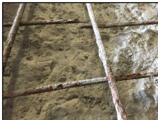
Figur 2.1 Byggeår 1983- Kloridkorrosjon angriper ulikt rundt og over lengden av jernet.
