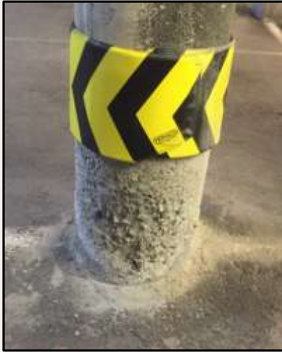
Byggeår 1985 Søylebunn nær innkjøring i fuktig miljø / vannlekkasjer / salt / frost.
