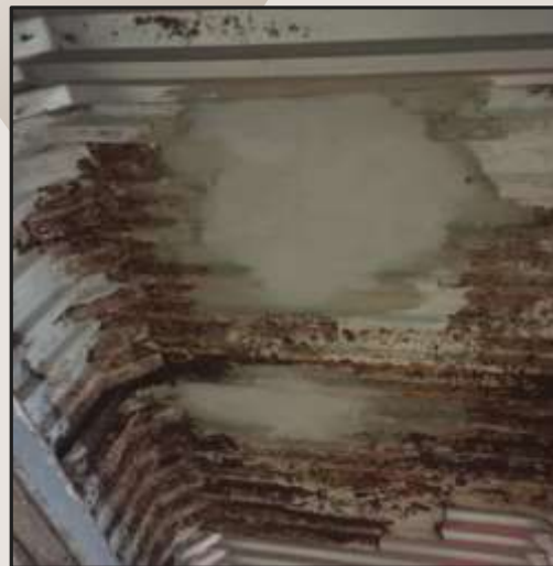
Byggeår 1985 Klorider trukket gjennom hele dekket – dårlig reparert en gang tidligere
