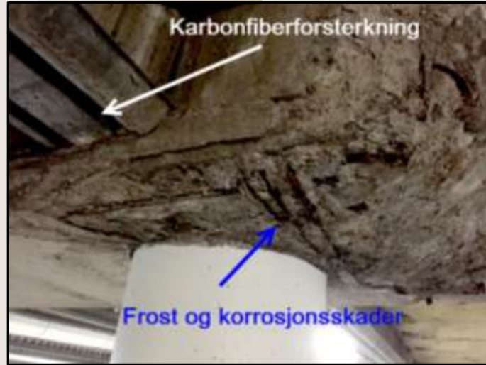
Byggeår 1985 Kapitel nær innkjøring i fuktig miljø / vannlekkasjer / salt / frost.
