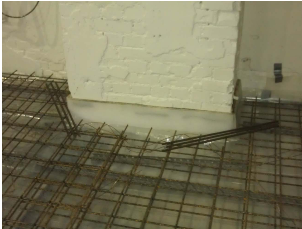
20 mm etafoam rundt søyler, 10 mm på vegg samt tilleggs armering for å motvirke riss.
