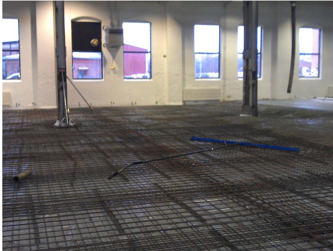
Dobbelt armert gulv, Armeringsnett K335.
